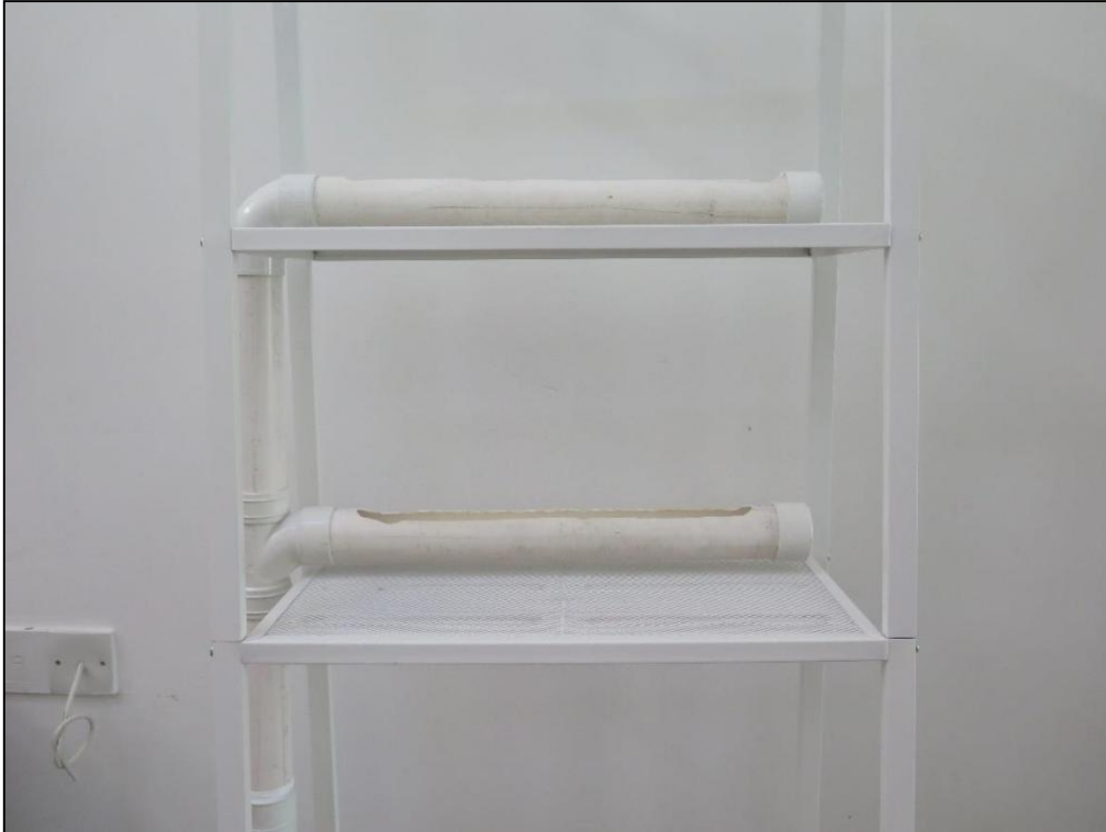
Langkah 2: Pemasangan sistem air keluar (outlet) pada rak.
