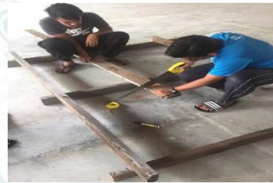
Foto 3.13 Membuat acuan penutup longkang
